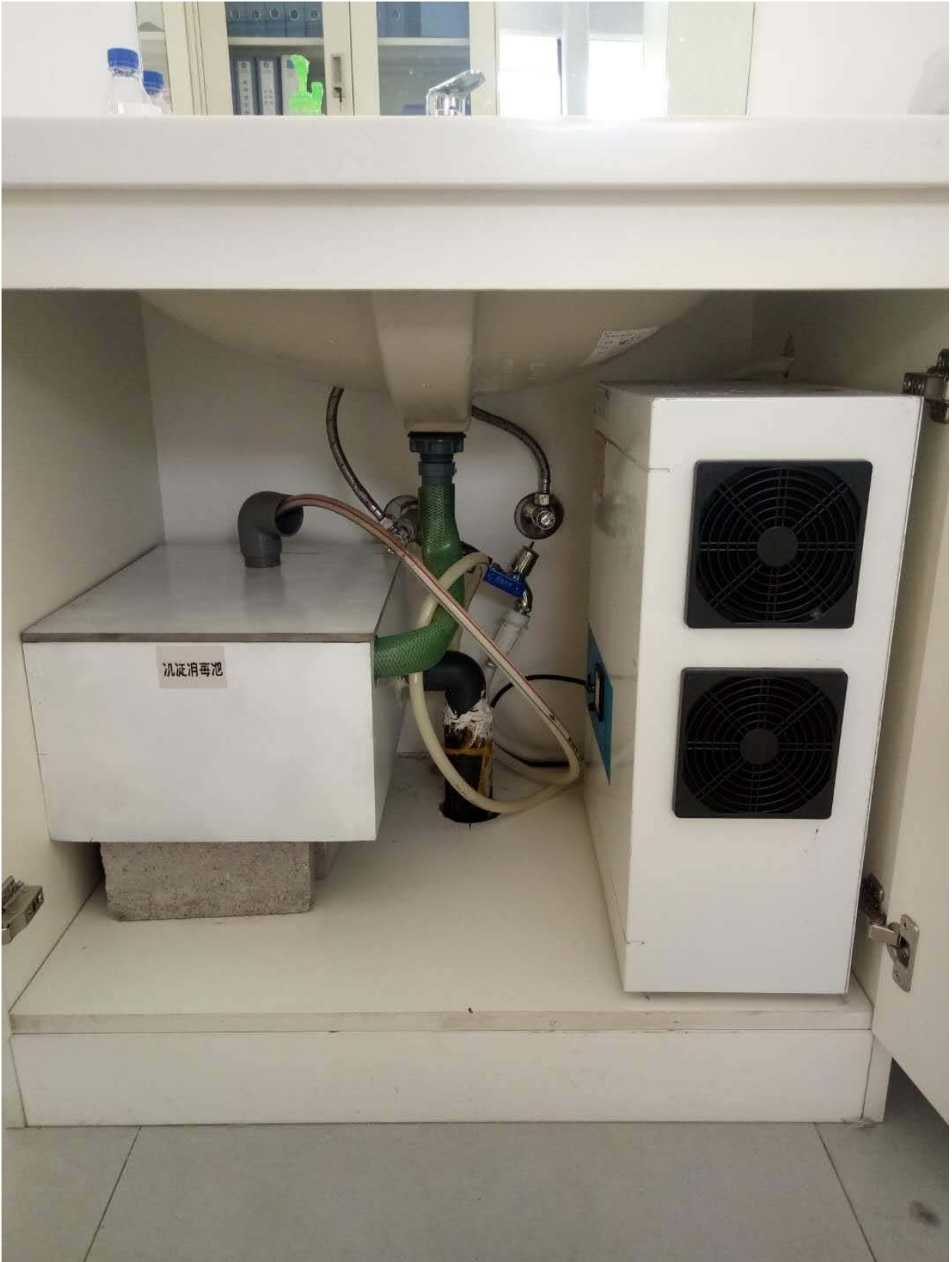
项目污水处理设备照片
